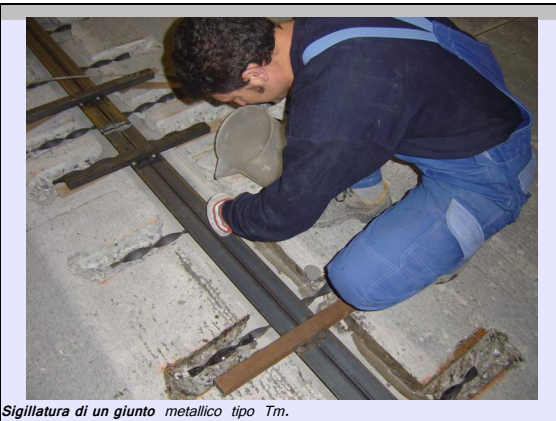
Sigillatura di un giunto metallico tipo Tm.
