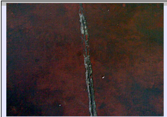
Giunto di taglio mal progettato con rottura da transito. Notare lo sbeccamento laterale del bordino. Le macchie sulla superficie, dovute al passaggio di carrelli gommati evidenziano inoltre uno strato d'usura povero.
